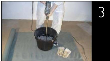
Mischen Sie die Marmorsteinchen mit dem Bindemittel ca. 3min. gründlich durch, bis alle Marmorsteinchen gleichmäßig benetzt sind (auch in den Eck- und Randbereichen des Eimers). Benutzen Sie dazu ein elektrisches Rührwerk (z. B. Bohrmaschine mit Rührkorb). Dieses Gemisch reicht für 1 m<sup>2</sup>. Legen Sie den Mischbereich mit fester Folie aus.
